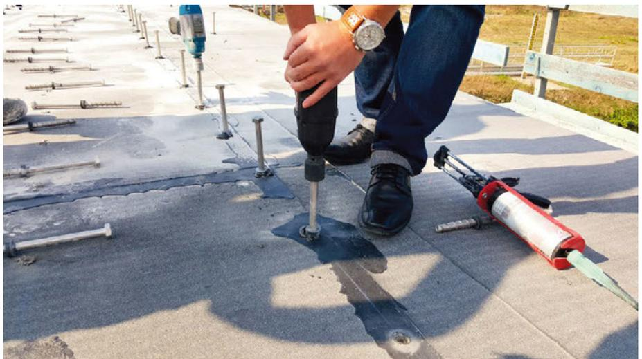
Abb. 2: Nachträgliches Aufbringen der Betonschraube auf eine bestehende Abdichtung
