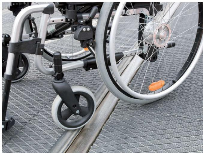
**Abb. 3:** veloStrail stellt z. B. einen barrierefreien Bahnübergang für Rad- und Rollstuhlfahrer, für Fußgänger mit Kinderwagen oder Gehhilfen sicher.
