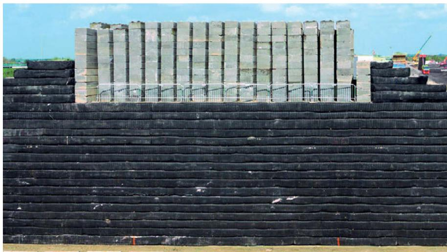
Abb. 4: Vorbelastung des geokunststoffbewehrten Brückenwiderlagers unter der Autobahn A 74, Venlo, Niederlande
