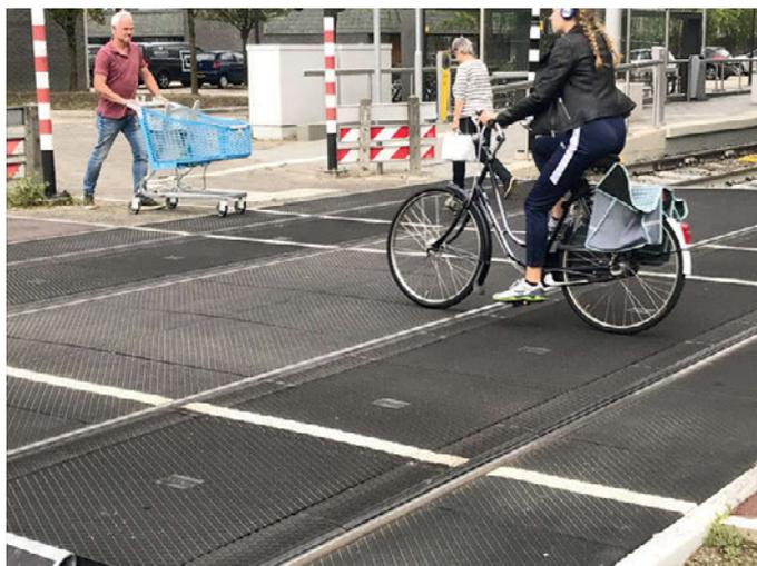
**Abb. 2:** Beim barrierefreien Bahnübergangssystem veloStrail wird ein Gummi-Wechselteil zwischen Schiene und Innenplatte eingesetzt und so die Spurrille geschlossen.
