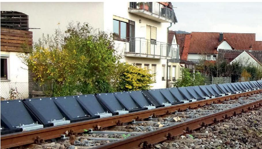
**Abb. 6:** Im Ammertal in Baden-Württemberg kam die Mini-Schallschutzwand mit einer Höhe von 360 mm über Schienenoberkante bereits erfolgreich zum Einsatz.
